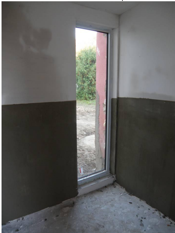
Fot. 5. Remont wiatrołapów
