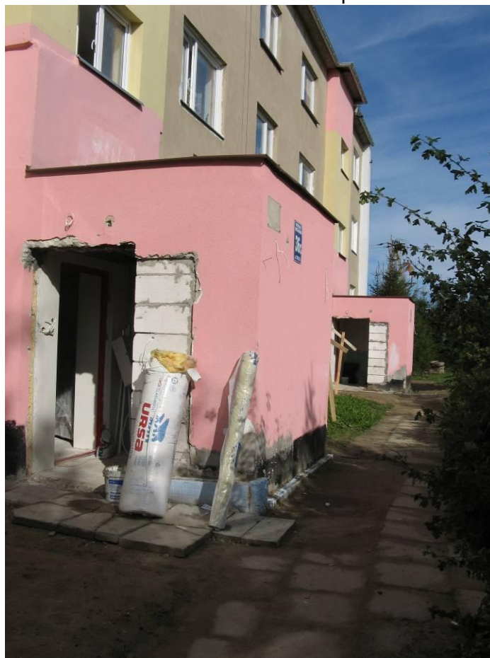
Fot. 3. Remont wiatrołapów
