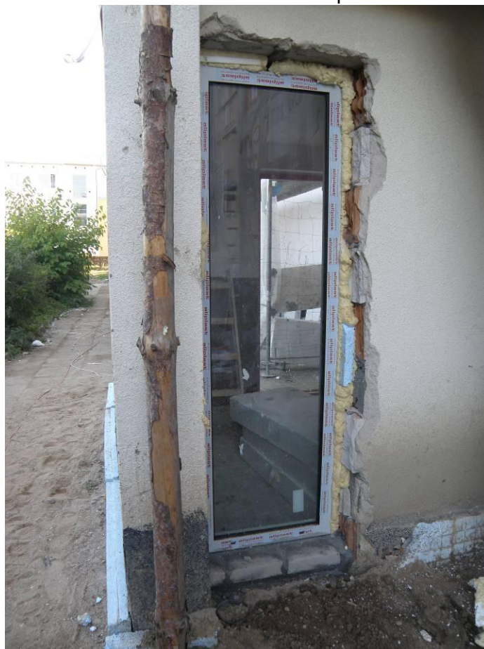
Fot. 7. Remont wiatrołapów
