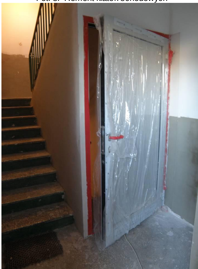
Fot. 8. Remont klatek schodowych
