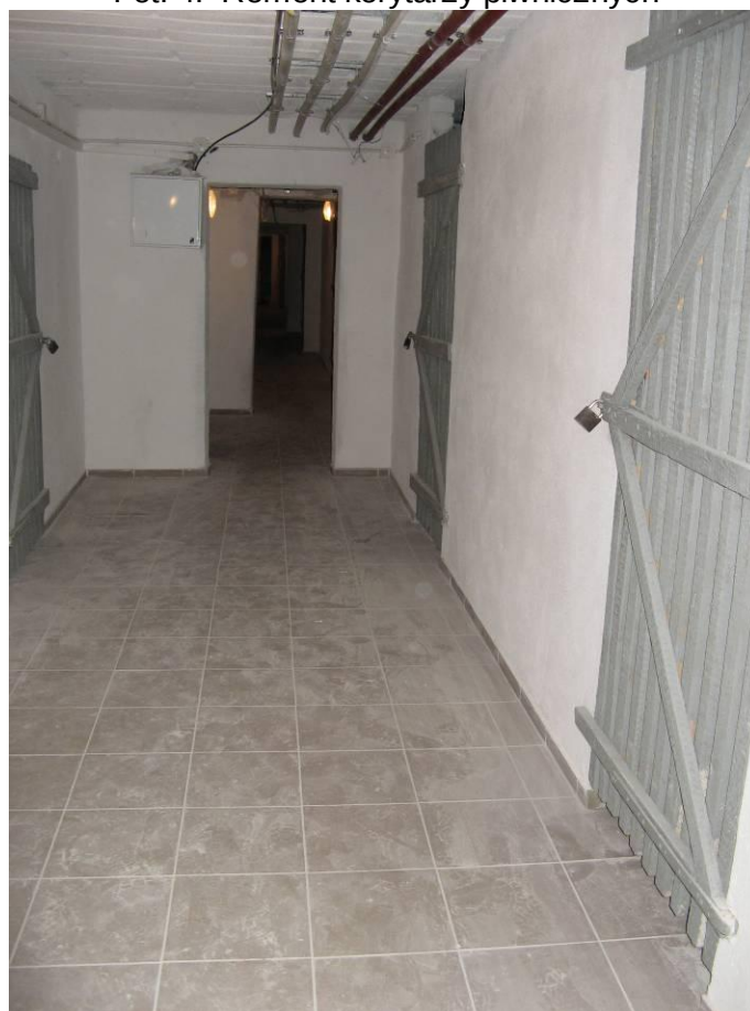
Fot. 4. Remont korytarzy piwnicznych
