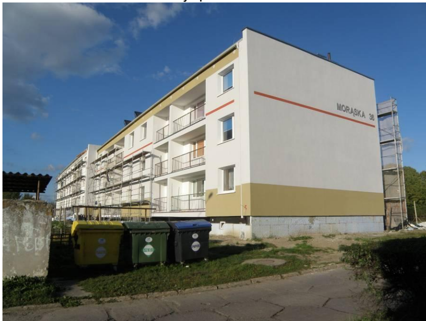
Fot. 9. Elewacja południowo-zachodnia.
